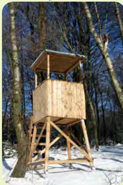
offene Kanzel mit 1,50 m Unterbau und Dach
