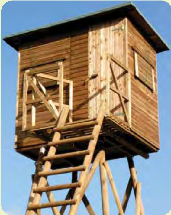
Schlafkanzel auf 3,50 m Unterbau mit Podest
