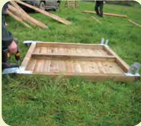
Die Montagehülsen werden unter den Kanzelboden geschraubt.
