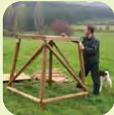
An manchen Plätzen, oft unter großen Bäumen, reicht ein Unterbau von 150 cm Höhe. Die Montage ist einfach.
