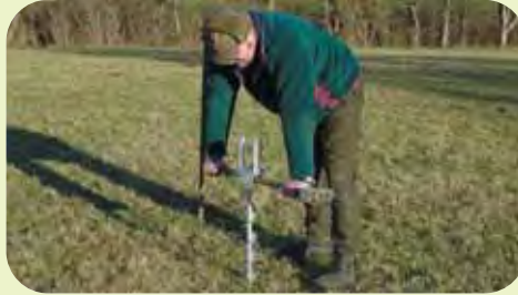
Nach dem Vorstechen, kann der Schraubanker wie abgebildet eingedreht werden.
