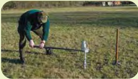
Bei sehr festem Boden verwenden Sie zum Eindrehen eine Eisenstange.
