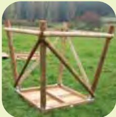
An manchen Plätzen, oft unter großen Bäumen, reicht ein Unterbau von 150 cm Höhe. Die Montage ist einfach.
